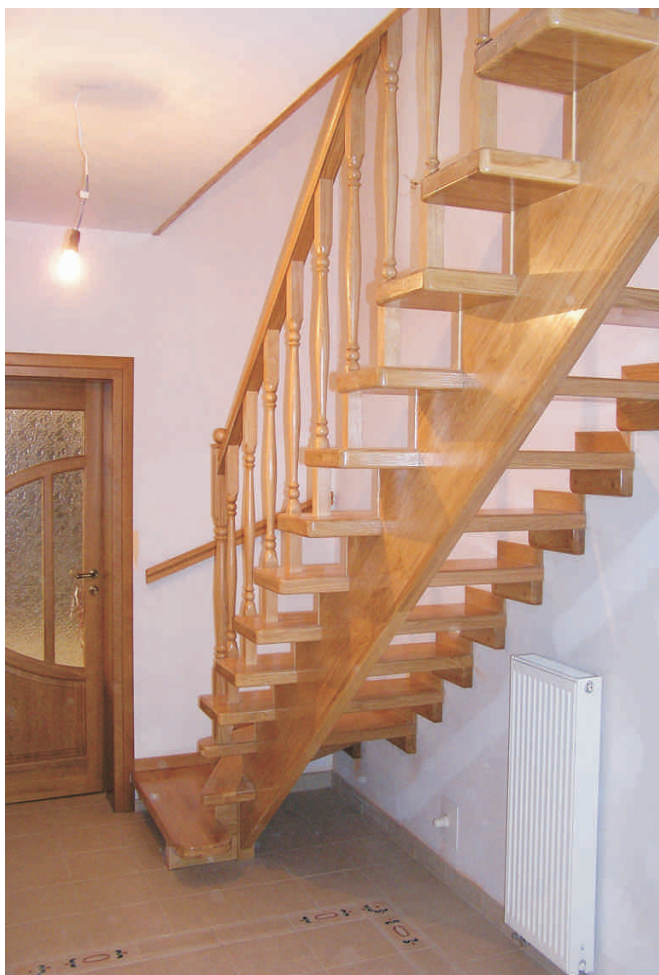
Schody dębowe konstrukcyjne z jedną wangą. Balustrada tralki
