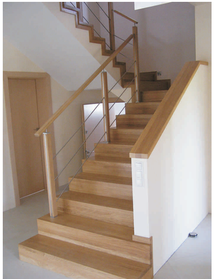
Schody dębowe z balustradą stalowo-dębową
