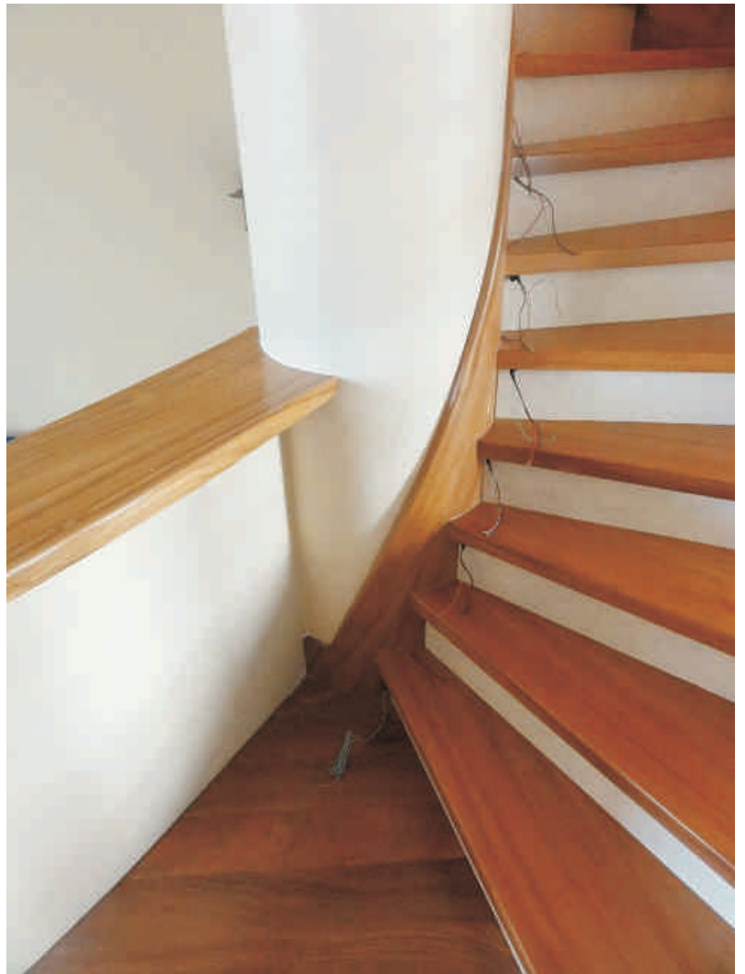
Schody gięte i parapet z dussie
