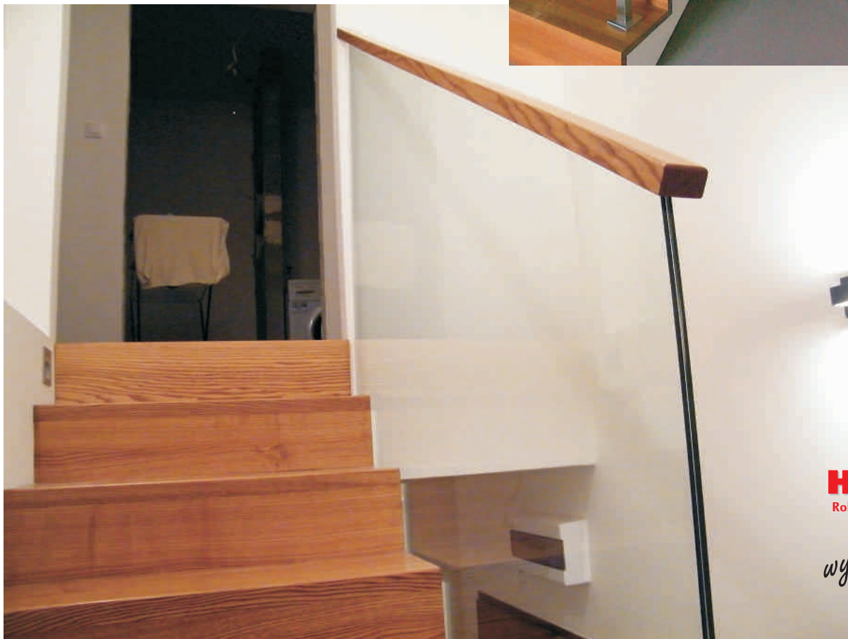
Schody jesionowe dywanowe z balustradą szklaną montowaną do boku. Pochwyt jesionowy
