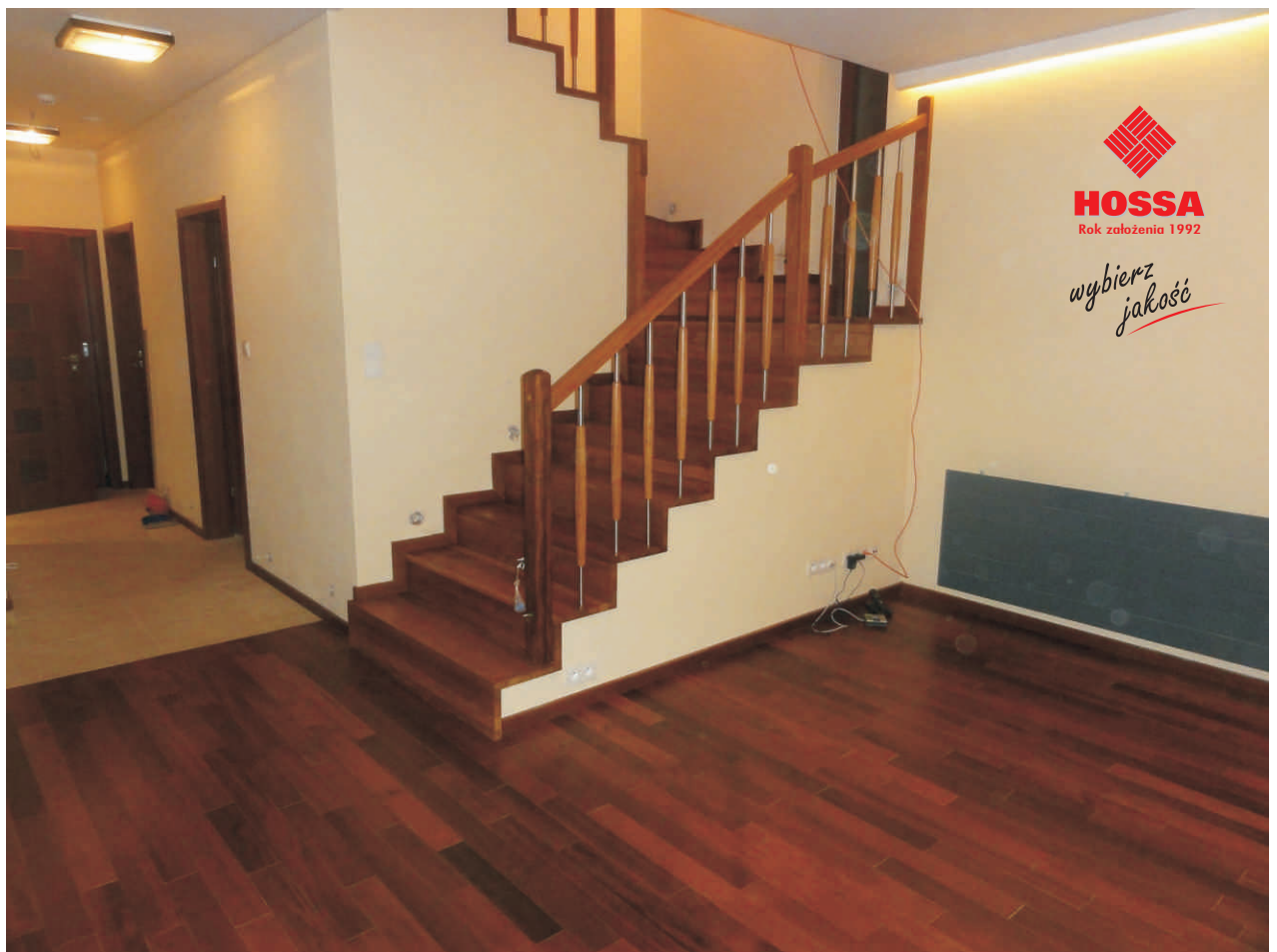
Schody dywanowe z merbau. Grubość stopnia i podstopnia 30 mm
