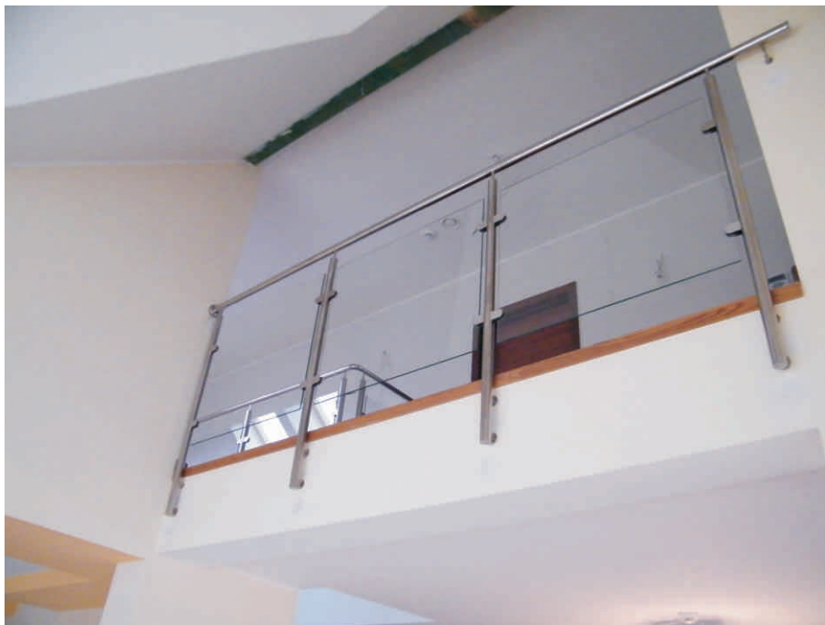
Balustrada stalowo - szklana montowana do przekroju stropu
