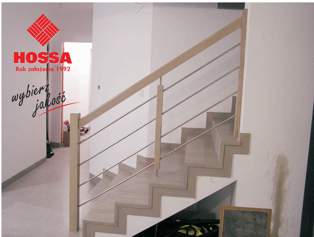
Schody barwione z mozaiki jesionowej. Balustrada stalowo jesionowa
