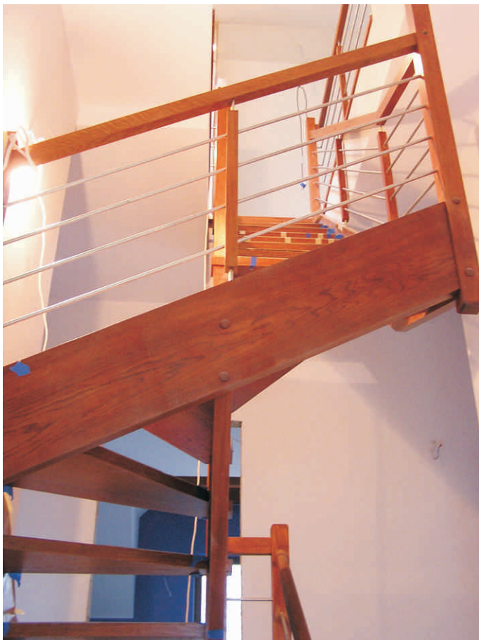
Schody dąb, barwione wiszące z balustradą stalowo-dębową
